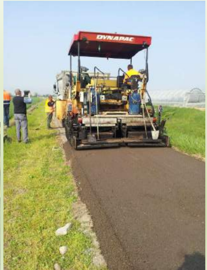
Stesa sottofondo CMR misto cementato
