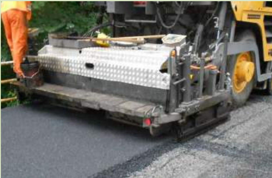
Stesa manto conglomerato bituminoso
