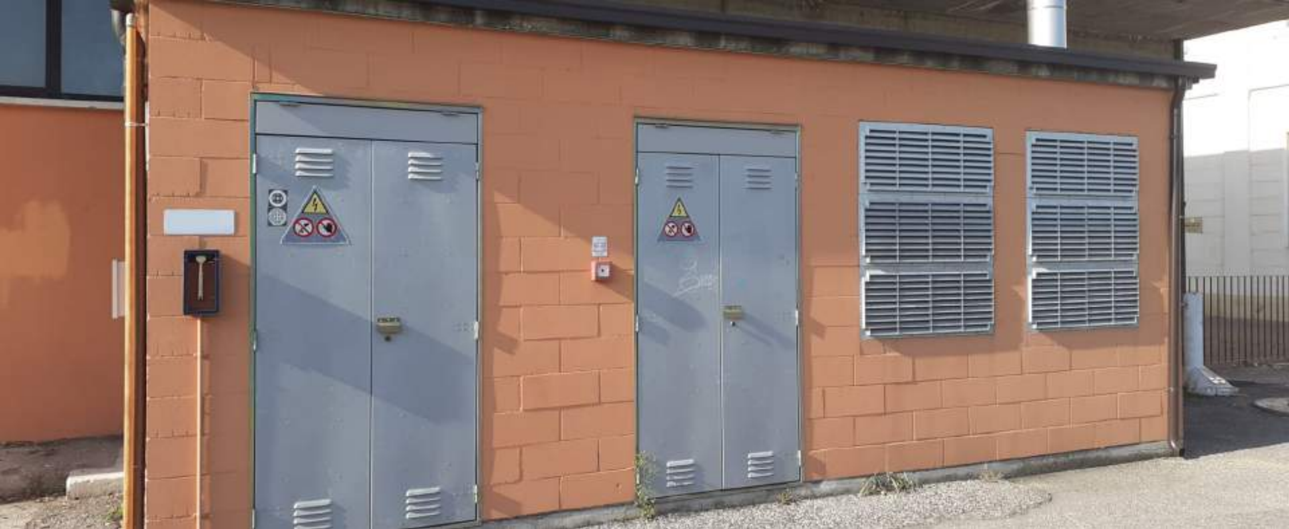
Impianto idrovro di via San Carlo
