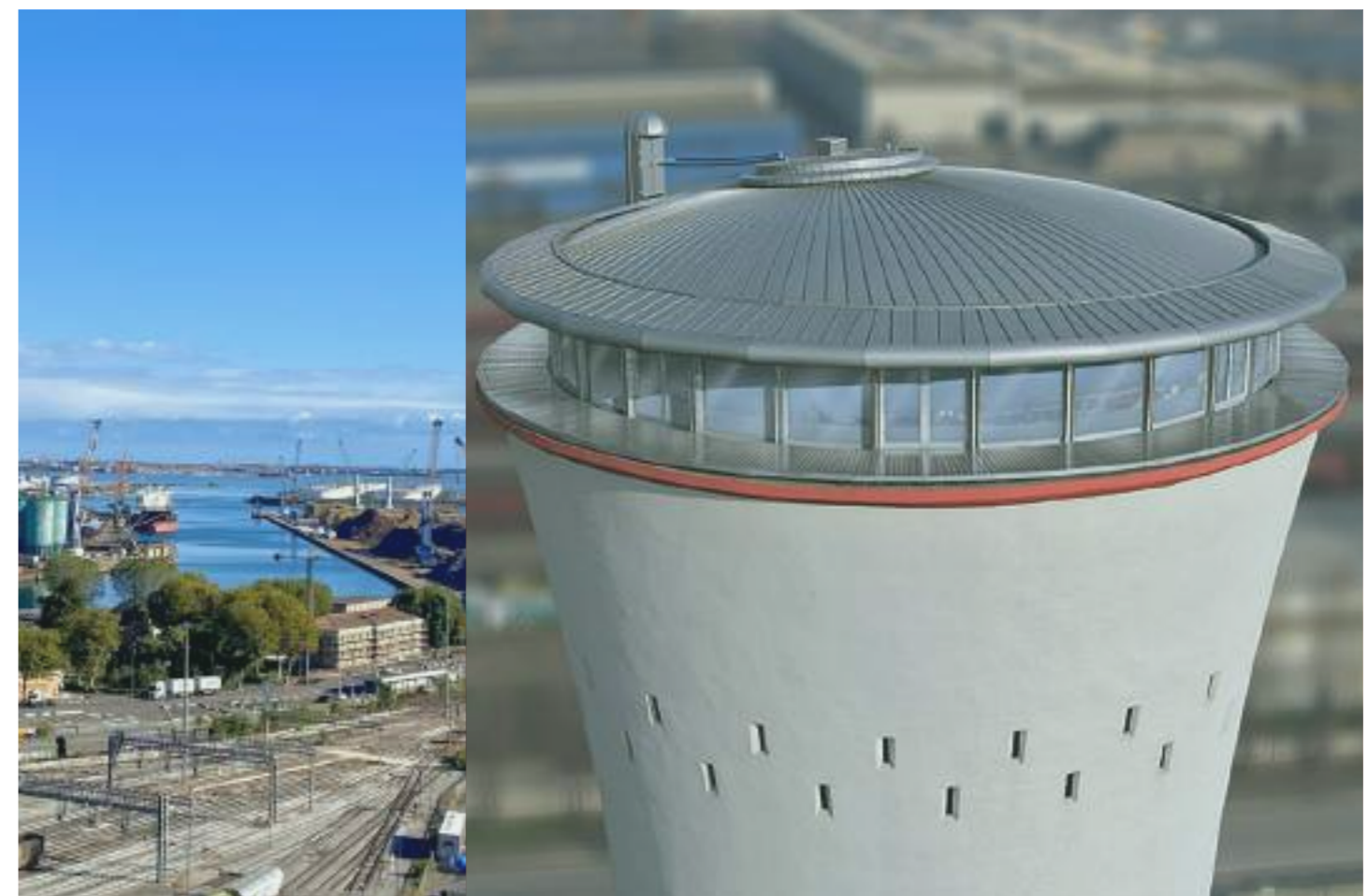
Osservatorio VHT. Vista della copertura in Zintek realizzata nel 2012.
